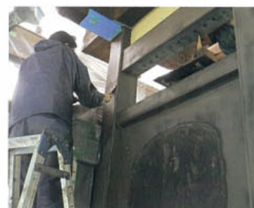
現場での下地作業
